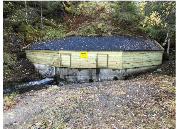
Figur 13: Kaldbekken - overbygd råvannskilde [Kilde: Brønnøy kommune]
