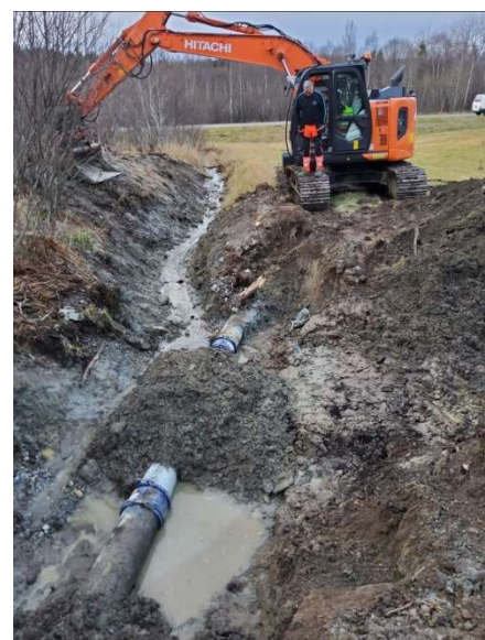
Figur 9: Utbedring av brudd på asbestrør.
