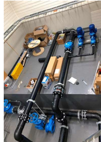
Figur 12: Vannbehandlingsanlegg på Vollan under bygging
