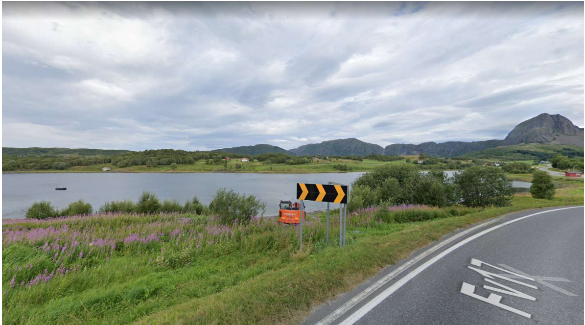
Figur 10: Tidligere renovasjon av ledningsnett i området Skille [3].
